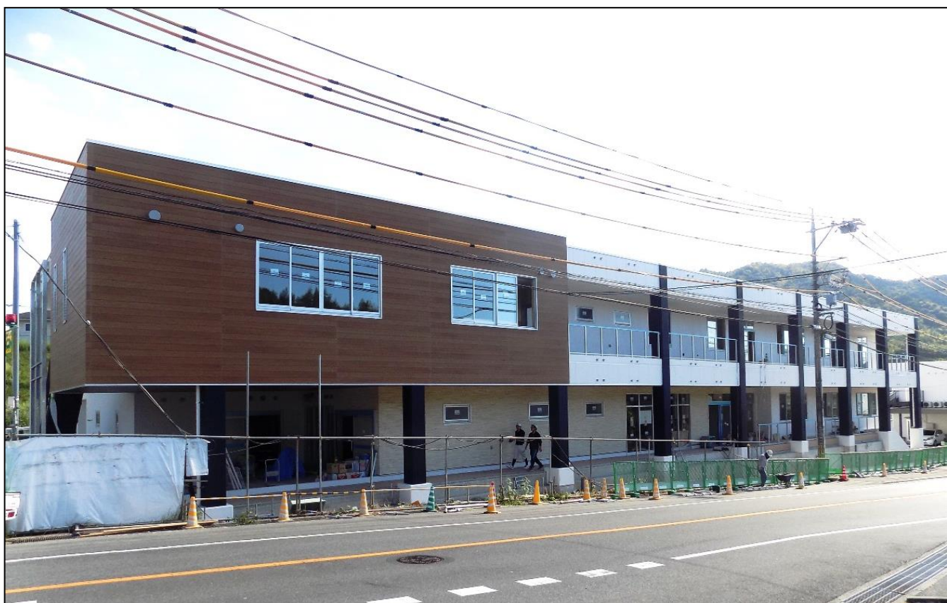
「宮領ワークセンター」(工事中) 十二月開設
