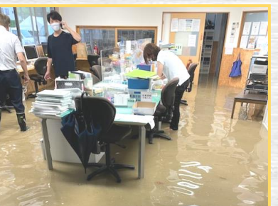
事務所の浸水状況
